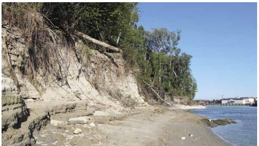
ABB 5: Uferrückbau Hainburg nach den Baumaßnahmen am 11.09.2011
