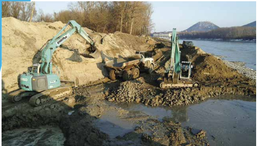
ABB 4: Uferrückbau Hainburg während der Baumaßnahmen am 14.02.2006
