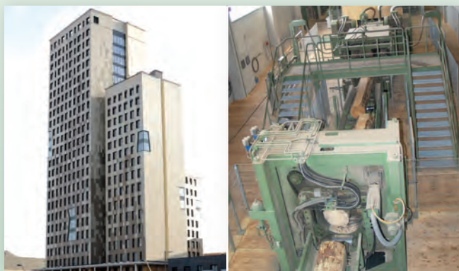
Leuchtturmprojekt Hoho Wien: Auch bei der Holzverarbeitung für den Holzbau fallen große Mengen energetisch nutzbarer Nebenprodukte an.
